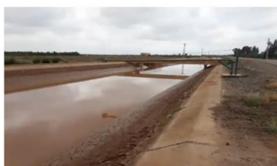
Barrage Al Wahda Capacité de stockage: 3,8 Milliards m 3
