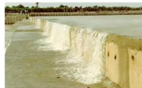
Seuils sur l'oued Souss pour la recharge artificielle de la nappe de Souss
