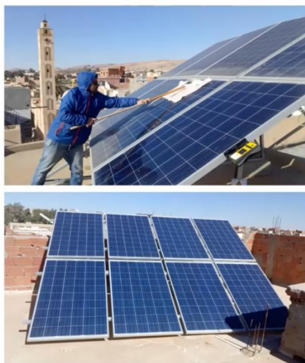
Nettoyage régulier des modules
