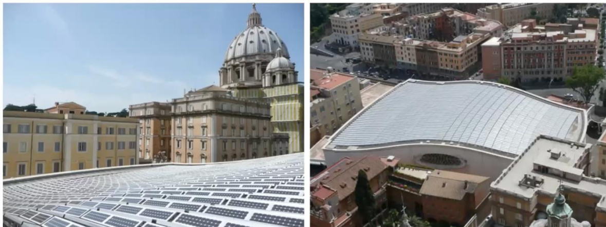
La toiture photovoltaïque de l'auditorium vue depuis la coupole de basilique Saint-Pierre (Rome)
