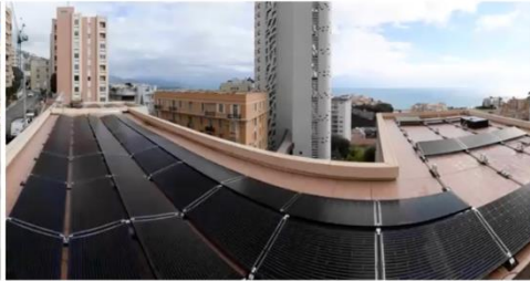
Revôres (exploitée par le Service de Maintenance des Bâtiments Publics)
