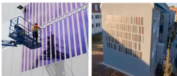
Panneaux souples et ultralégers d'HELIAITEK (fabriqués en Allemagne)
