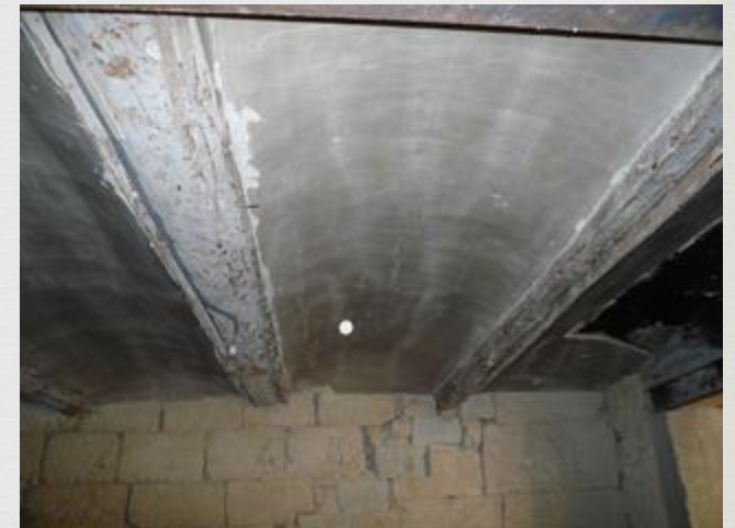
Plancher en voutain de plâtre
