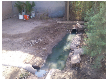
Mauvaises conditions d'hygiène
